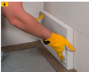
Multipor WI compact plus nach dem Andrücken 2 bis 3 cm verschieben, sodass die Stege umklappen und eine vollflächige Verklebung gewährleistet ist
