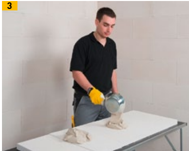
Ausreichend Multipor Leichtmörtel auf die Multipor WI compact plus auftragen
