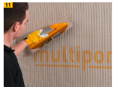
Multipor Gewebe als Armierungslage einbetten
