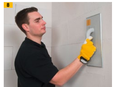
Eventuelle Unebenheiten können mit dem Multipor Schleifbrett egalisiert werden. Fehlstellen sind mit dem Multipor Füllmörtel auszubessern
