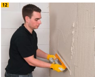
Abziehen der Armierungsschicht
