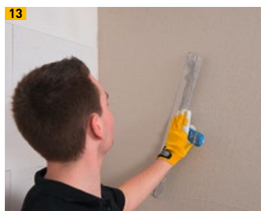
Glätten des Multipor Leicht- und Armierungsmörtels
