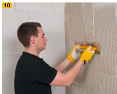
Multipor Leichtmörtel aufkämmen
